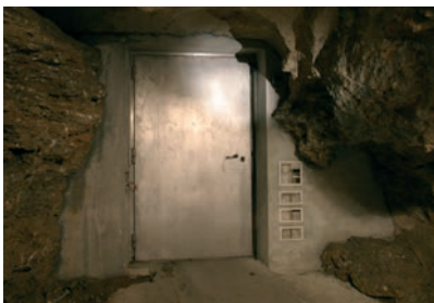
La porta blindata. Si notino a destra gli aeratori.
